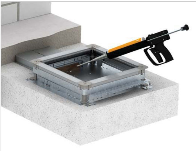
Bild 2: Einbringen des Brandschutzschaums in den Kanal
