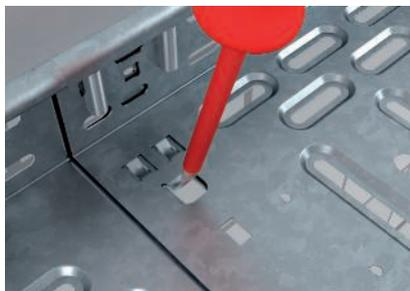
Umbiegen der Sicherungslaschen im Boden.
