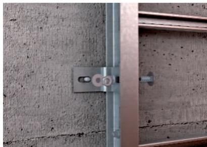
Montage mit verschraubten Befestigungswinkeln.
