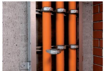
Kabelinstallation mit Bügelschellen 2056 BS U M an den Sprossen der Steigeleiter.
