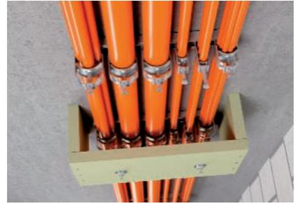
Montage über Profilschienen.
