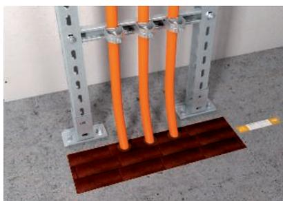
Verschluss der Deckenöffnung mit einem zugelassenen Abschottungssystem.
