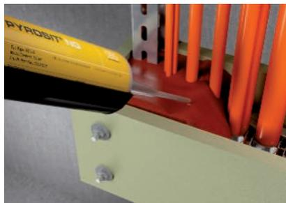
Auffüllen der Kabelzwischenräume mit Brandschutzschaum PYROSIT® NG.
