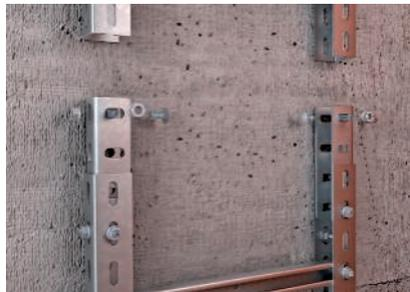
Stoßstellenausführung mit verschraubtem Verbinder.
