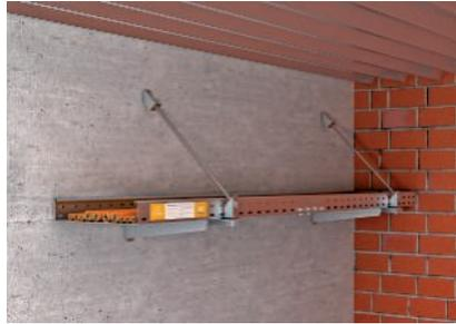
Wandmontage mit Gewindestangensicherung schräg.
