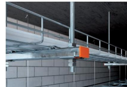
Anschluss der Gewindestange an der Montageschiene.
