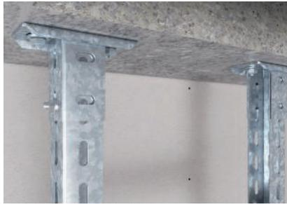
Deckenbefestigung der Leiterholme mit angeschraubten Kopfplatten.
