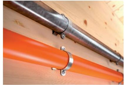
Kabelverlegung mit Einzelschellen und im Rohr, seitlich am Holzbalken.
