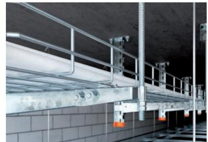
Montage der Gewindestangensicherung durch Anschlussbauteil an der Ausleger Spitze.
