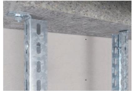
Deckenbefestigung der Leiterholme mit angeschraubten Montagewinkeln.
