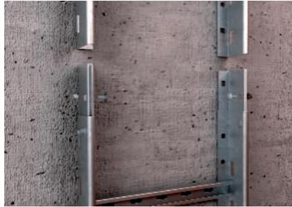
Stoßstellenverbindung mit verschraubtem Verbinder.
