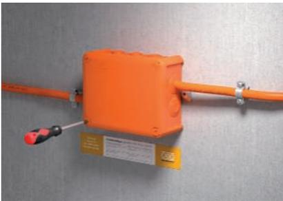
Box mit Deckel schließen und Kennzeichnungsschild anbringen.
