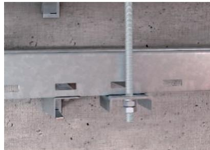
Befestigung der senkrechten Gewindestange am Anschlussbauteil.
