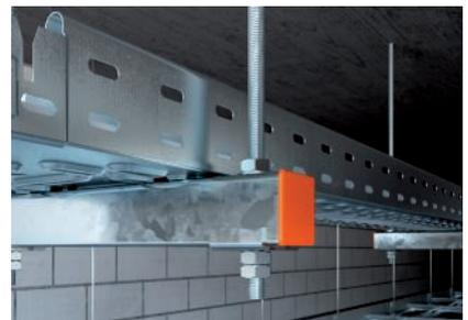
Anschluss der Gewindestange an der Montageschiene.
