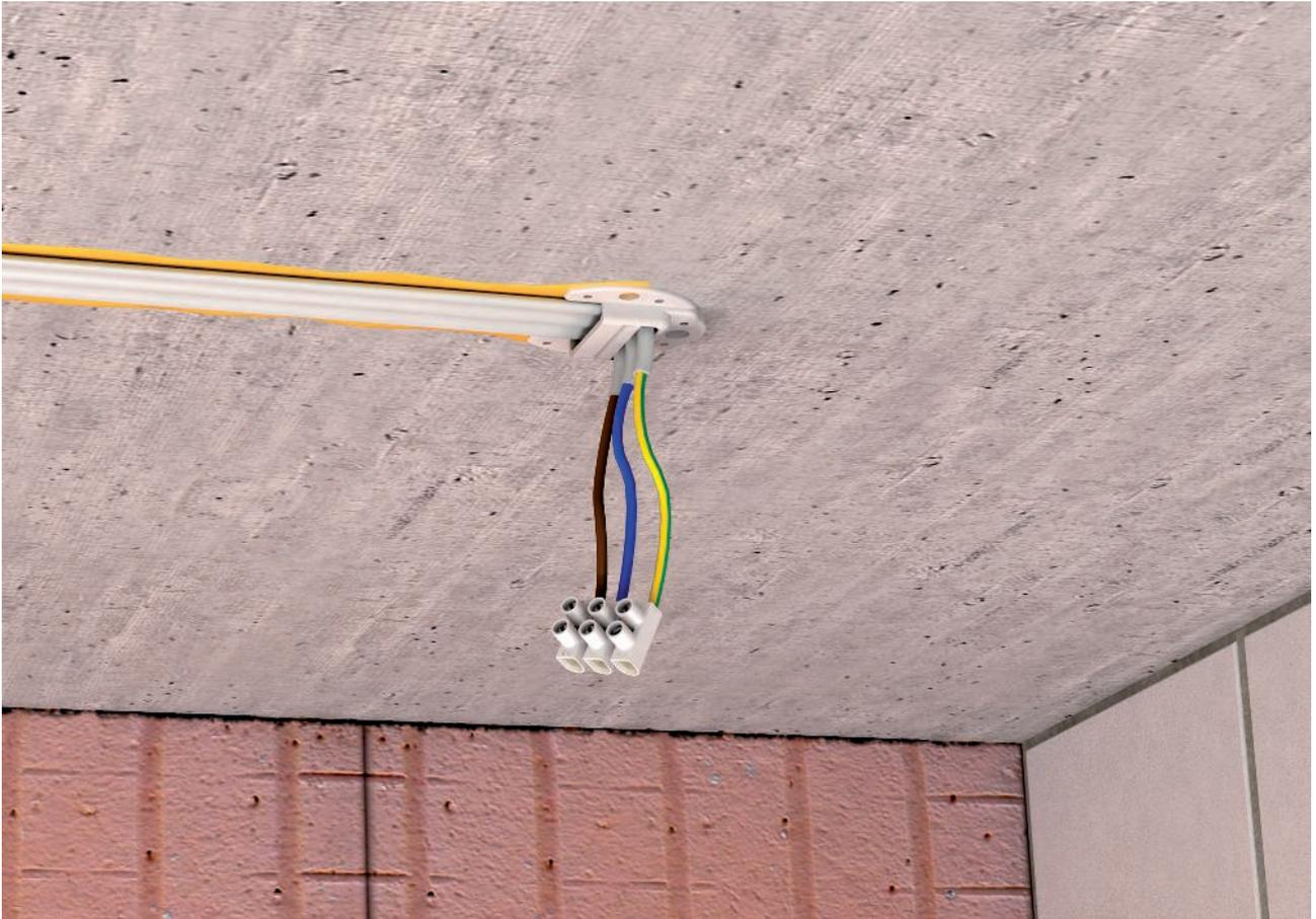
Die Abzweig-/ Lüsterklemme besteht aus einem isolierenden Kunststoffgehäuse, welches als Berührungsschutz für den Klemmeinsatz aus Stahl/ Messing dient. Somit können bei ordnungsgemäßer Anwendung keine spannungsführenden Teile berührt werden. Die Enden von Litzenadern müssen mit Aderendhülsen eingelegt werden, damit wird die Gefahr der mechanischen Beschädigung und Bruchgefahr der Einzellitzen durch die sich drehende Klemmschraube ausgeschlossen.
