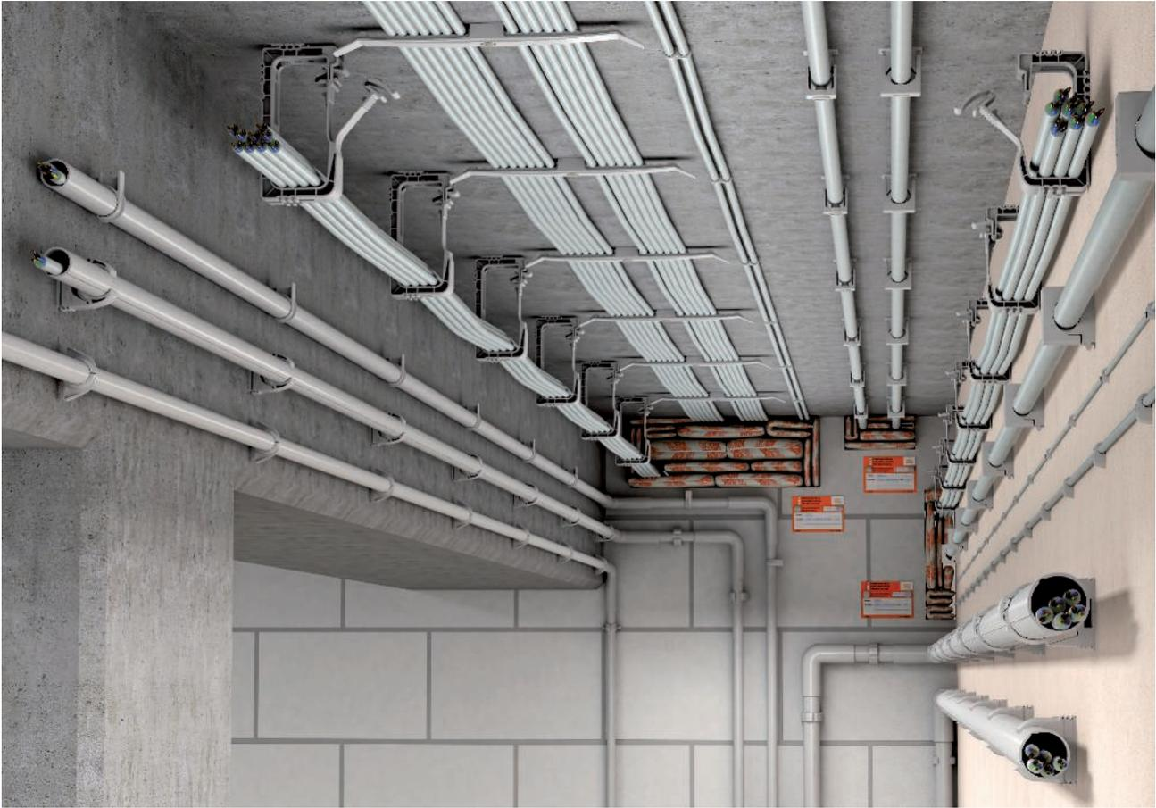
Befestigungsschellen werden mit ihrem maximalen Spannungsbereich als Nenngröße in mm angegeben. Somit kann leicht die passende Schelle zum geplanten Kabelvolumen ermittelt werden. Liegt der benötigte Spannungsbereich an der Grenze zwischen zwei Nenngrößen, z. B. 16 mm, empfehlen wir, die kleinere Nenngröße einzusetzen.
