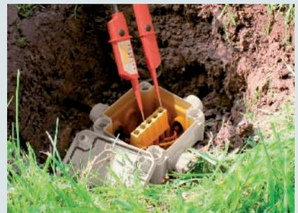
Die Anwendung ist denkbar einfach: Für kleinere Kabelabzweiggästen wird Aquasit einfach mit einer handelsüblichen Kartuschenpistole sauber vergossen, während Aquasit für größere Kästen in praktischen, passenden Mischbeuteln verarbeitet werden kann.
