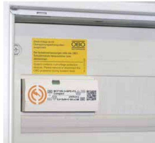
> Bild 7: SPD-Anschluss in „V-Verdrahtung“
